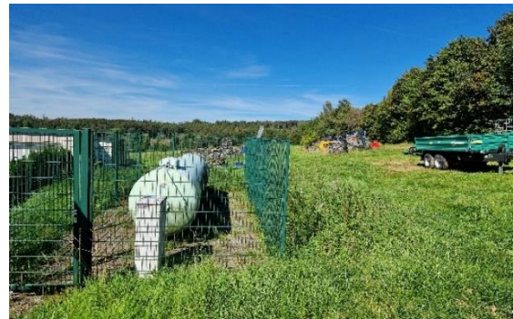
Abbildung 56: Zentraler Tank einer Flüssiggas-Sammelversorgung (eigenes Bild)
